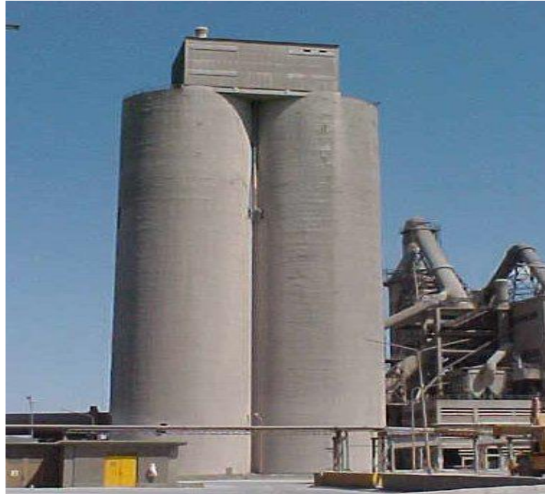
Figura 17: Silos de homogeneización y almacenaje
