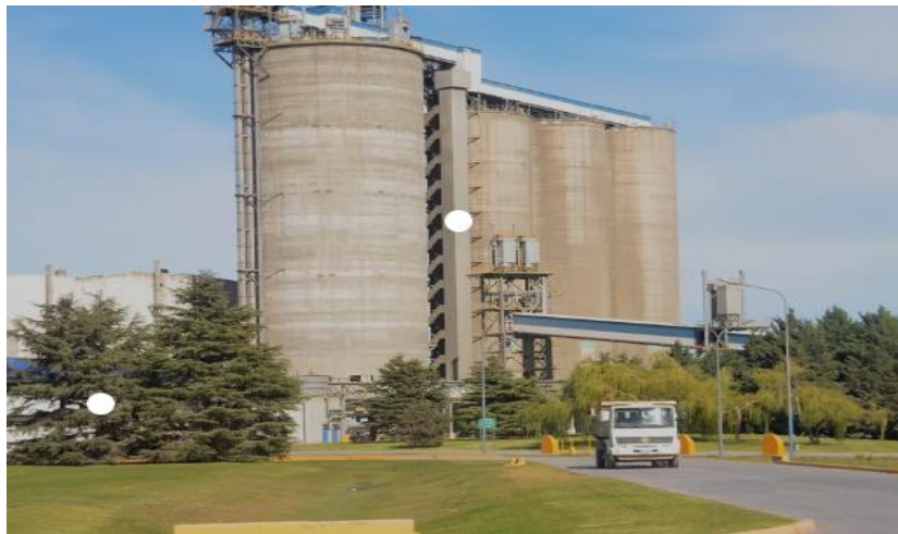
Figura 23: Silos de almacenamientos de cemento.
