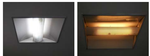
Figura 38. Diferencia entre luminaria (La Ampliación)
