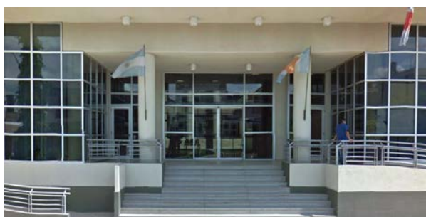
Figura 22. Fotografía del acceso al edificio por calle H. Yrigoyen
