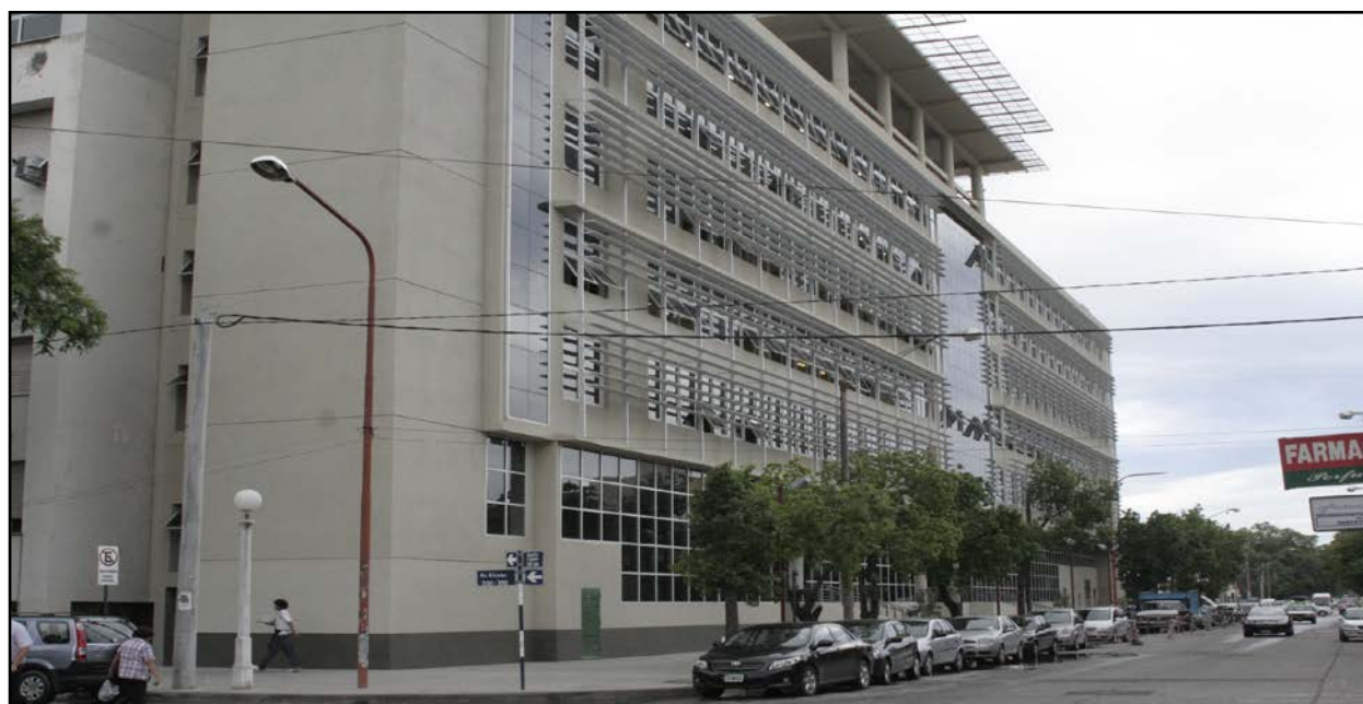
Figura 2. Fachada principal del edificio
