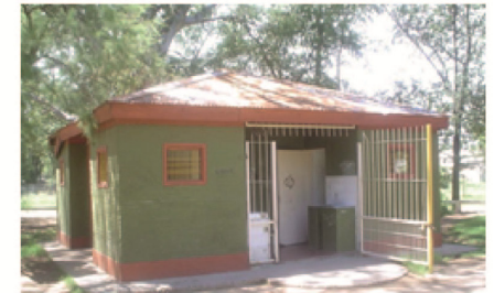
Baños públicos ubicados en zona de parrillas
