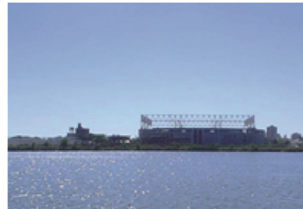
Megaestadio, en construcción.
