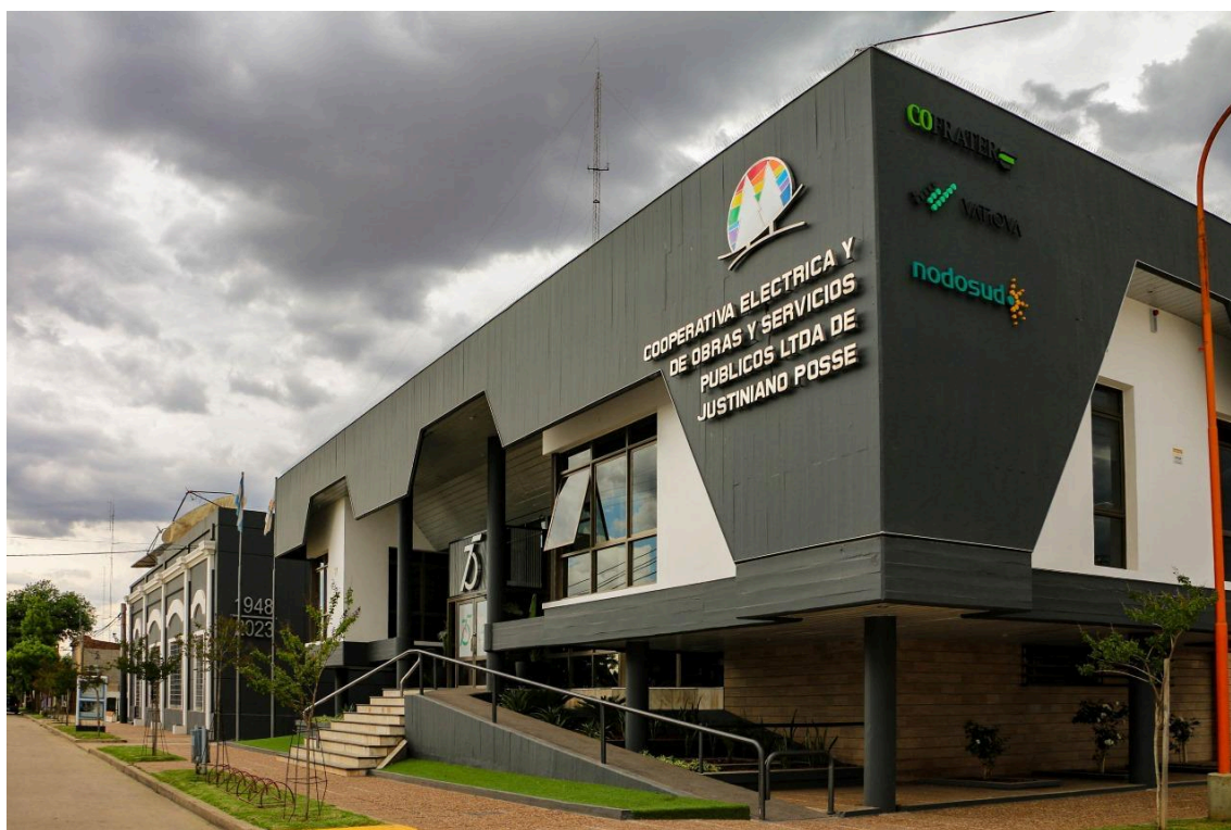
Imagen 4. Cooperativa Eléctrica de Justiniano Posse. Fuente: Material institucional.
