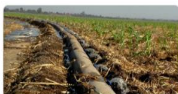
IV. Instalación de sistemas de riego tecnificado
