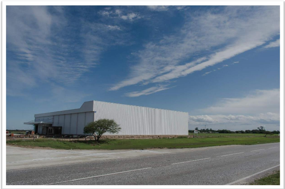
Figura 9: Centro de distribución en construcción en el año 2018.
