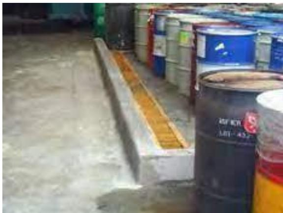
Figura 3: muro de contención hecho con cemento.
