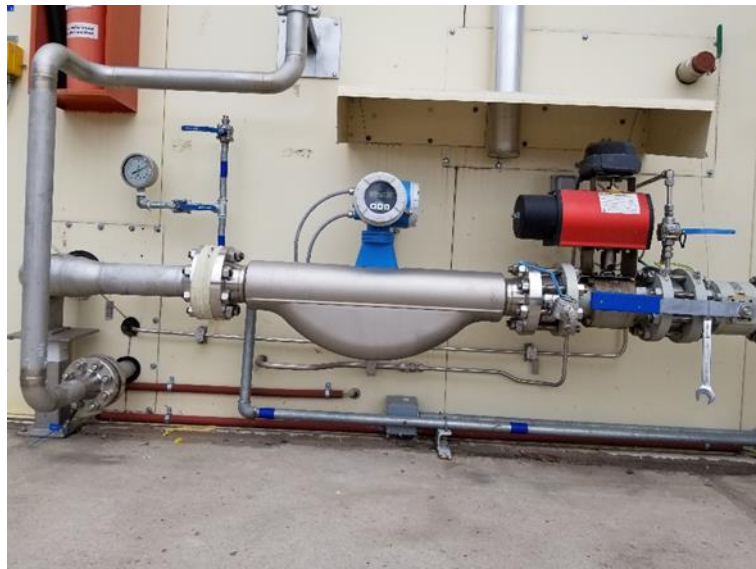
Ilustración 53 - Caudalímetros de gas natural instalados en TG6 y TG7 – fotografía extraída por el autor
