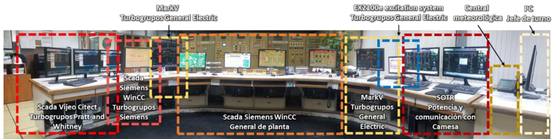
Ilustración 39 - Sistemas existentes en sala de control – elaboración propia
