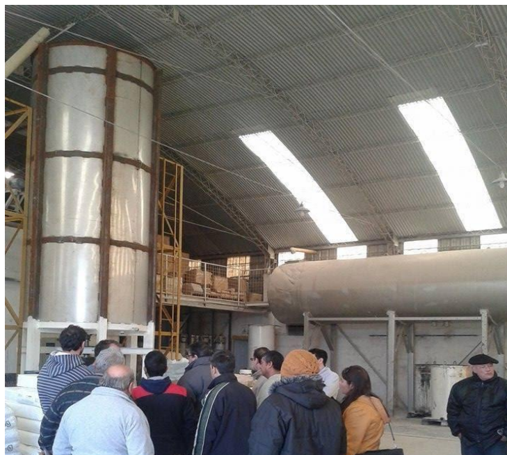
Imagen N° 6: Vista interior del sector planta principal.
