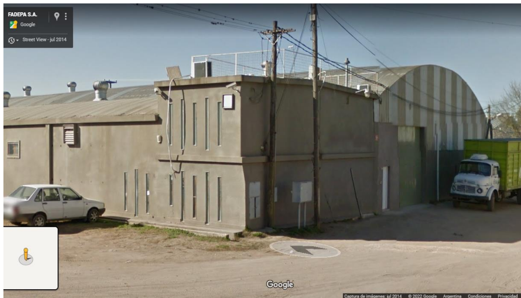
Imagen N° 1: Vista exterior de las oficinas y sector planta principal.
