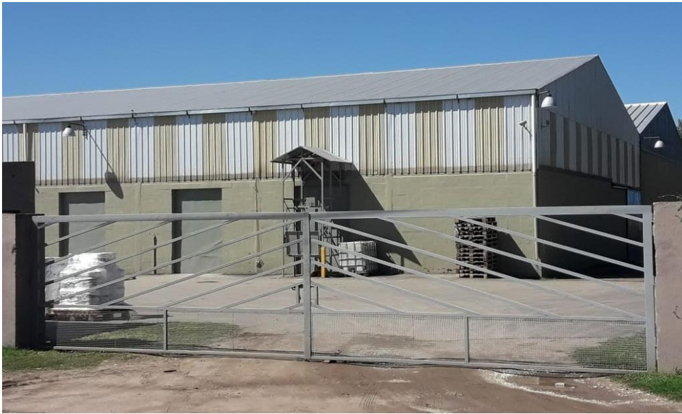
Imagen N° 9: Vistas del exterior del sector depósito.
