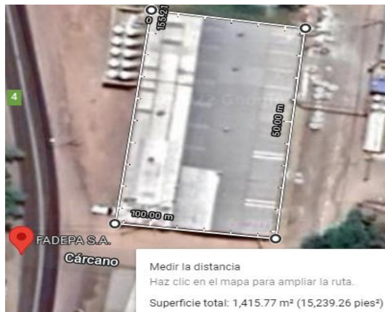
Imagen N° 5: Vista aérea del sector planta principal.
