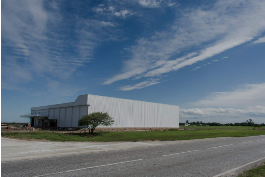
Figura 3 (Centro de distribución en construcción año 2018 – Fuente Canvas, 2021)
