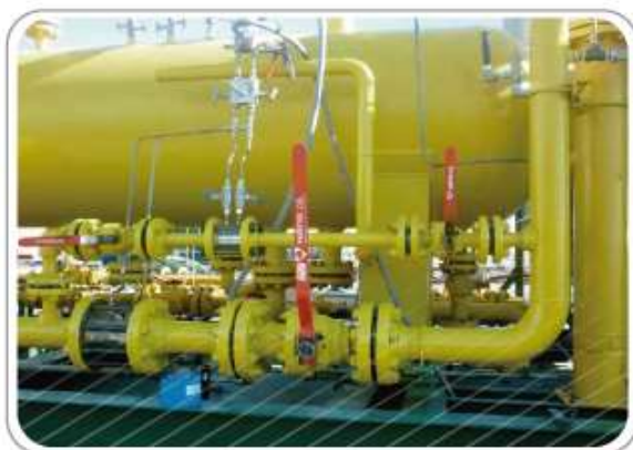
Medición de Gas a través de V-Cone 4" y computador de caudal con AGA 8 (cromatografía)
