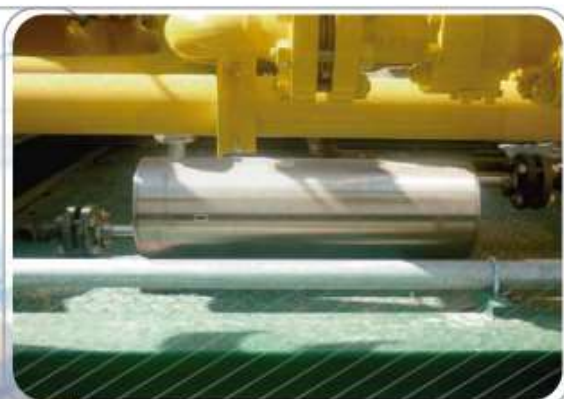
Mediciones de caudal de Petróleo y densidad a través de caudalímetros máscicos.
