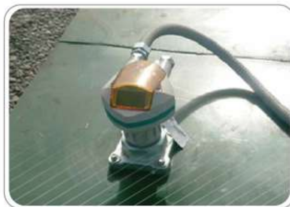
Medición de Nivel en Gauges Tanks mediante radares ultrasónicos
