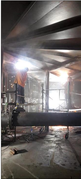
Imagen N° 4 y 5. Soldadura en espacio confinado con andamio en tanque cortador, Planta Sur.
