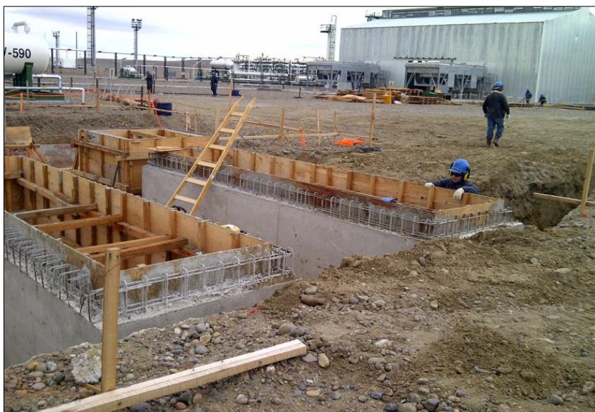
Imagen N° 8. Encofrado de cámaras.
