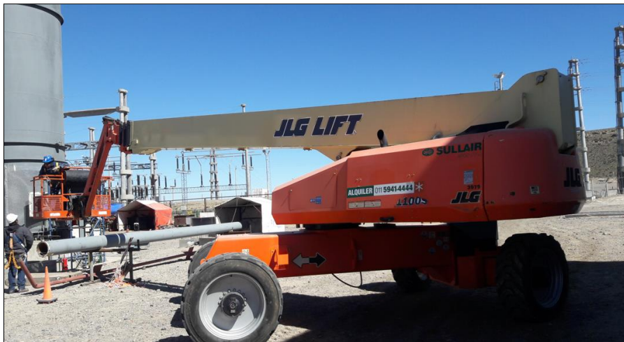
Imagen N° 6. Operario manejando plataforma elevadora para trabajo en altura con motor a explosión, brazo telescópico.
