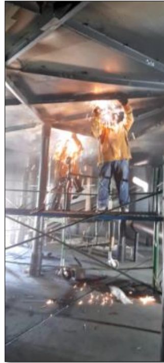
Imagen N° 4 y 5. Soldadura en espacio confinado con andamio en tanque cortador, Planta Sur.
