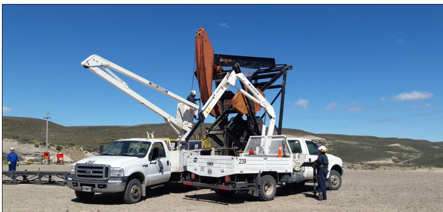
Imagen N° 9. Dos cuadrillas en conjunto realizando cambio de estrobo en cabeza de mula.
