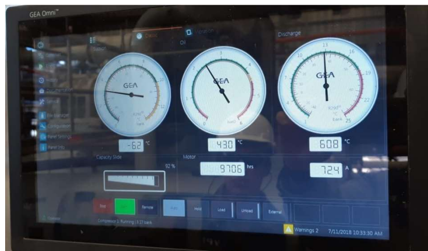
Figura 11: Foto extraída del panel de operación de compresor de propano mientras no se utilizaba el economizador. Elaboración propia
