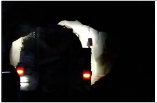
Figura 16: Labor de sección no adecuada para el paso del equipo
