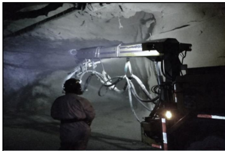
Figura 3: Aplicación robotizada de shotcrete en superficies. Fuente: (Rey, 2006)
