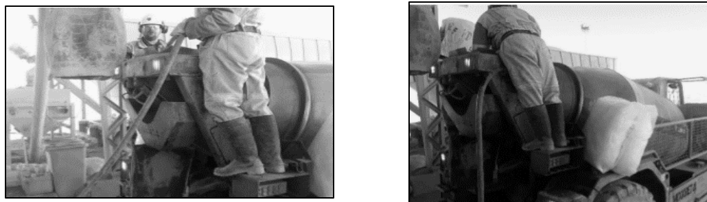
Figura 4: A la izquierda, agregado de agua con manguera. A la derecha, agregado manual de fibras
