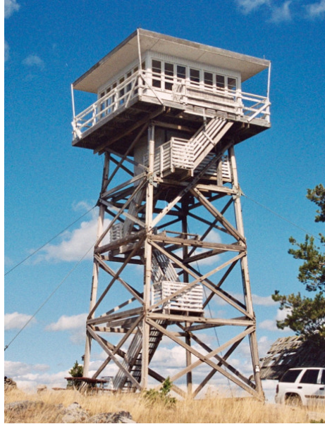
Figura 1. Torre anti-incendios en los Estados Unidos.
