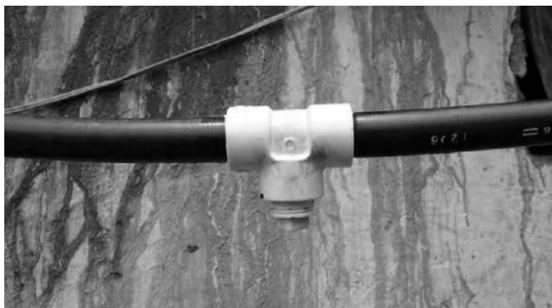
Figura N° 12: Extracción del agua acumulada.
