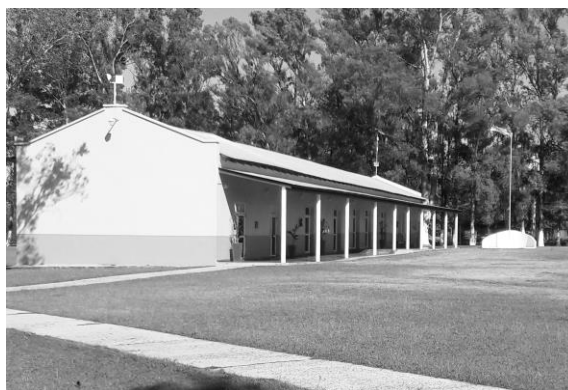
Figura n° 7 – Sector SUM, aulas, dormitorios y baños.
