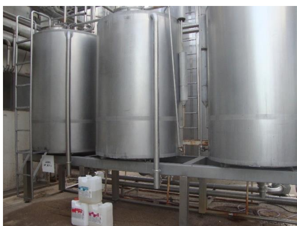
Figura 37. Sistema CIP
