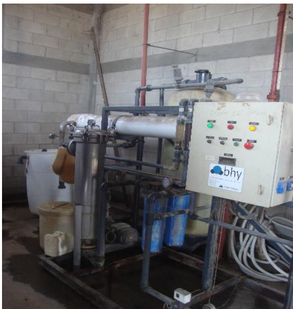
Figura 36. Sistema de ósmosis inversa
