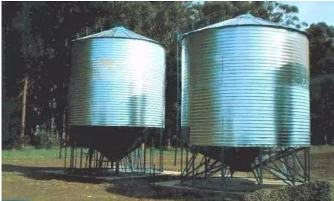
*Figura 3: Dos silos de serán de 3 mts de altura con capacidad de almacenaje para 190 TN. Una noria de 60 TN/hora – 15 Mts de altura.*
