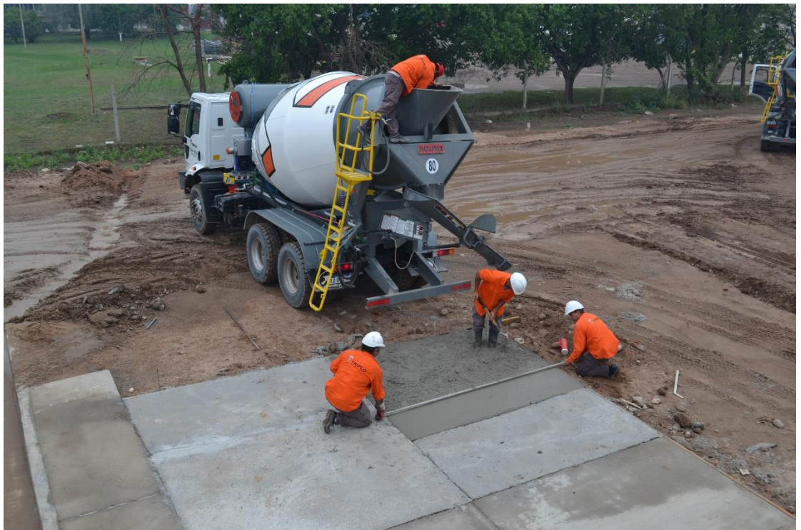
Ilustración 7 Hormigonado de piso
