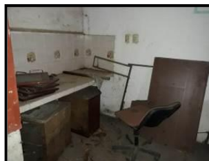
Figura 40.Sector Patio. Fuente: Cámara Fotográfica.
