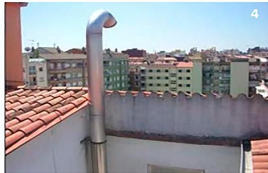
Chimenea de evacuación del helio gas: 1.- Conexión de la chimenea en la jaula de Faraday; 2.- Equipo con la chimenea acabada; 3 y 4.- Aspecto exterior de la chimenea. Se trata de un equipo Signa 1,5 T de G. E.
