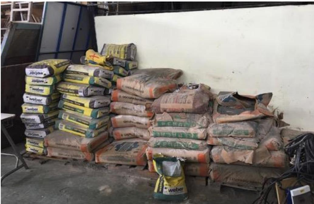
Figura 18. Materiales de trabajo almacenados incorrectamente.
