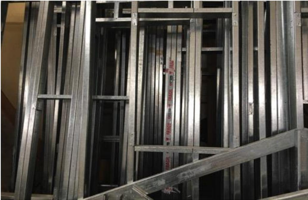
Figura 19. Materiales de trabajo almacenados incorrectamente
