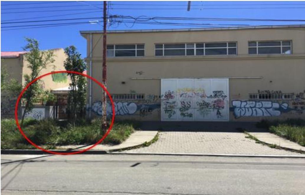
Figura 32. Salida de emergencia obstruida desde el exterior del taller.
