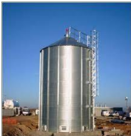
Figura 11. Silo para almacenaje de aceite
