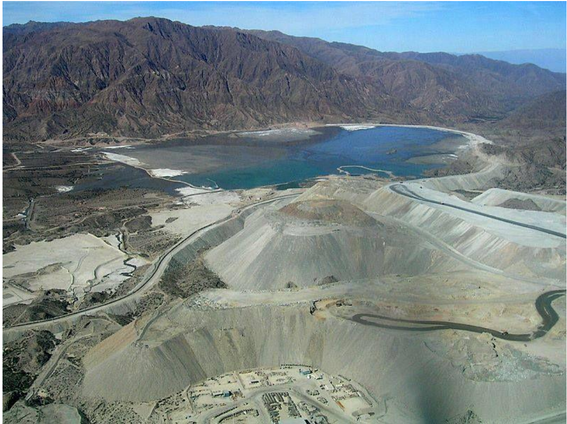
(Mina Bajo La Alumbra, Dique de Cola)
