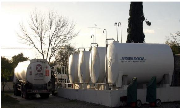
Figura 10. Bocas de expendio corralón.
