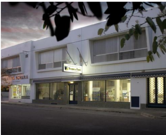
Figura 11. Sede administrativa frente.
