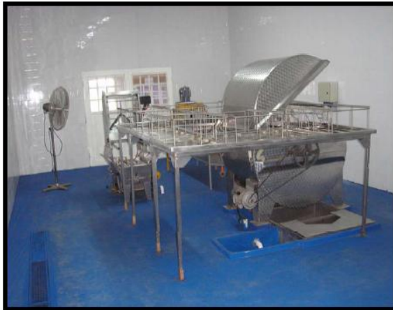
Sala de extracción.
