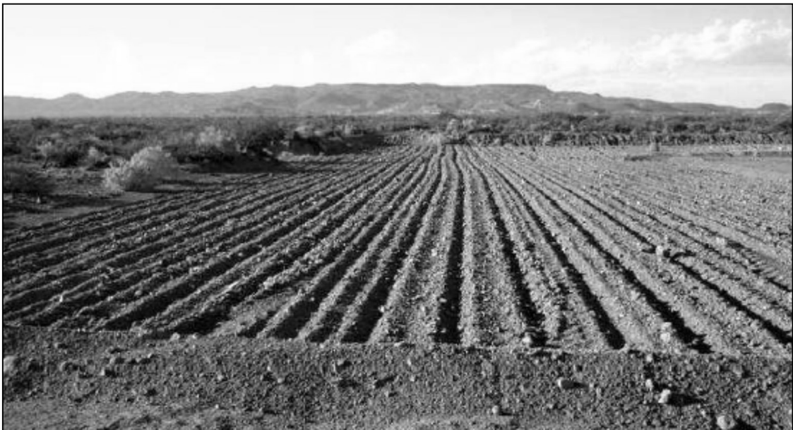
Figura 16 – Escarificado sobre piso de cantera
