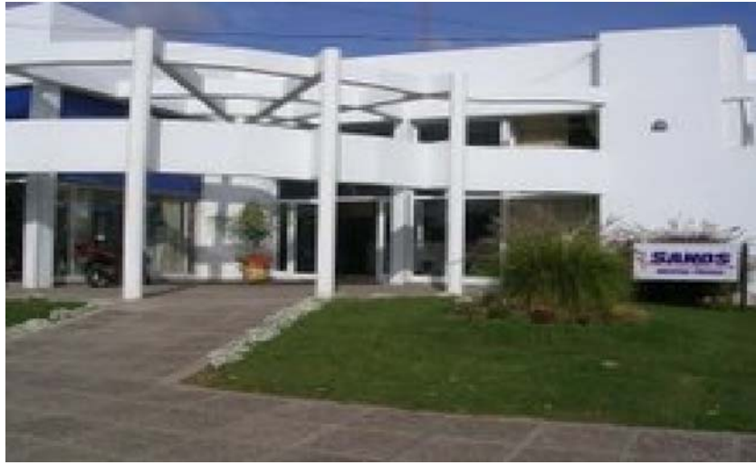
Vista de frente del Edificio principal
