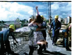
Toma 16: una mujer se acerca corriendo hacia los obreros y se abrazan con gran felicidad. Loc (voz en off)_y despedite también de los muchachos de la eterna construcción.
