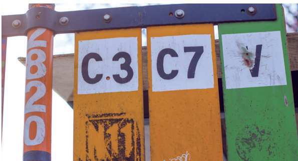
Señales dañadas a través del tiempo
