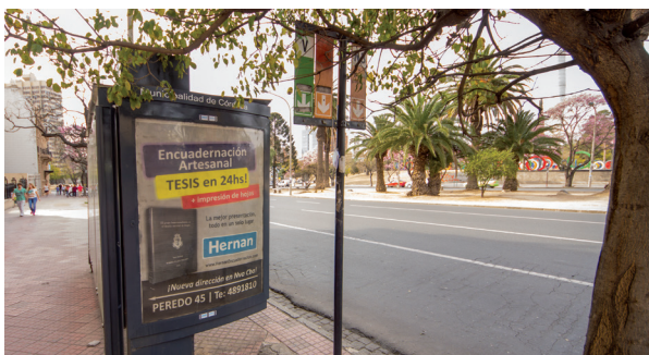
Poste con señales ubicado incorrectamente
