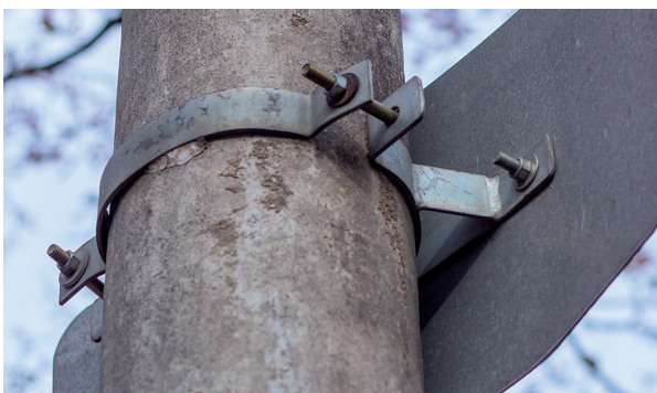
Ejemplo de abrazadera utilizada sobre poste de luz
