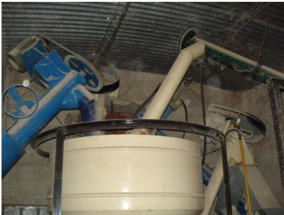
Figura 5 Vista de la planta de alimentos balanceados de la granja
