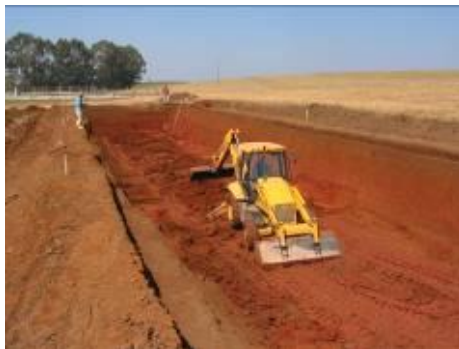
Figura 9. Excavación para la construcción de la cámara de digestión de un biodigestor
