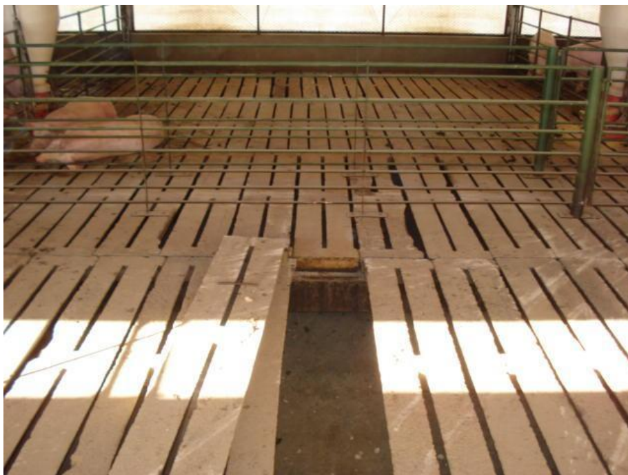
Figura 2. Vista del piso perforado de uno de los galpones de terminación
