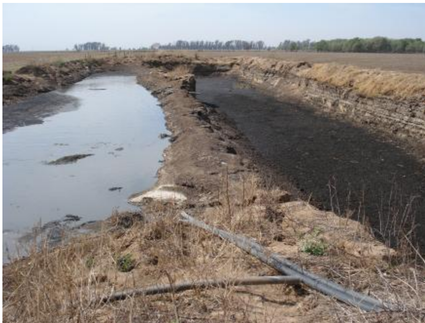
Figura 3. Vista de las lagunas de almacenaje de los efluentes
