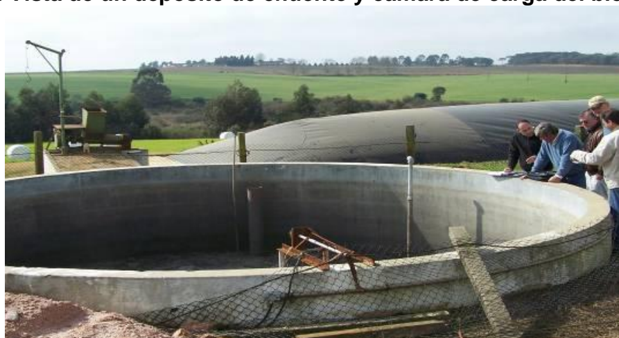
Figura 11. Vista de un depósito de efluente y cámara de carga del biodigestor
