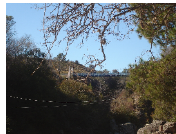
Puente Colgante 16/07/2008 – 15.32 hs.
