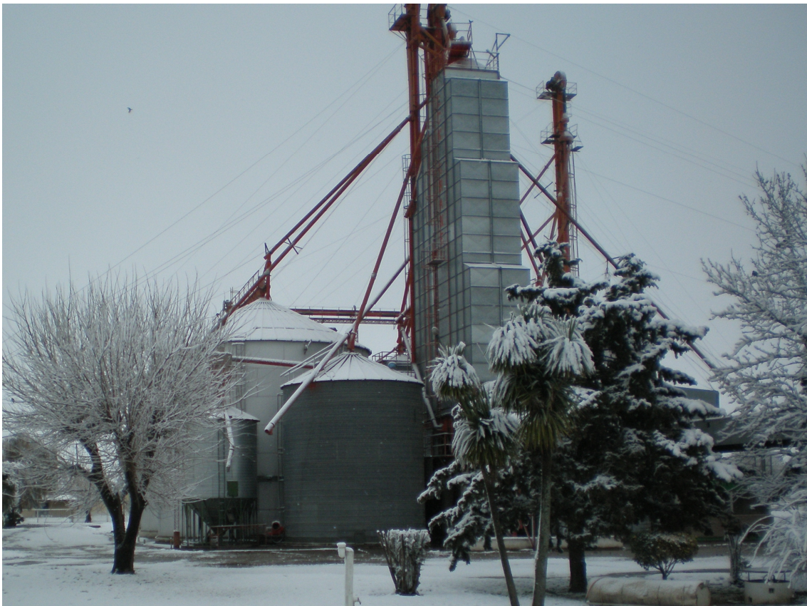
Imagen 4: Planta de Silos de Santa Eufemia
