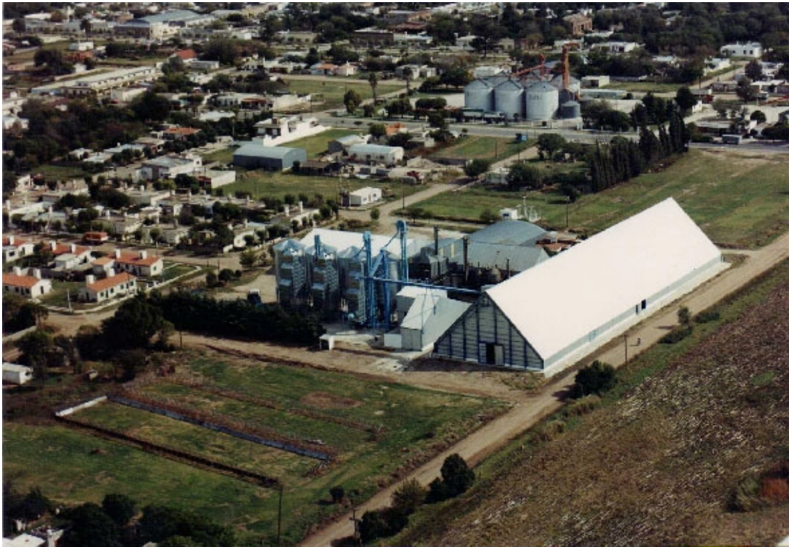
Imagen 1: vista aérea, instalaciones de la Planta Seleccionadora de maní
