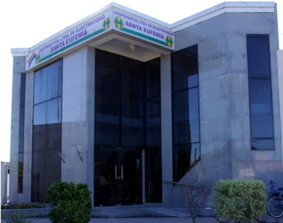
Imagen 14: frente de la Cooperativa de Electricidad
