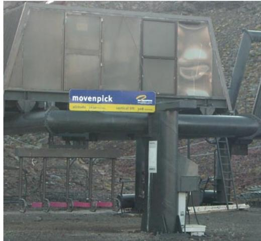
Señal de identificación actual sostenida por un soporte trasero que lo mantiene firme contra la estructura de acceso al medio de elevación.
