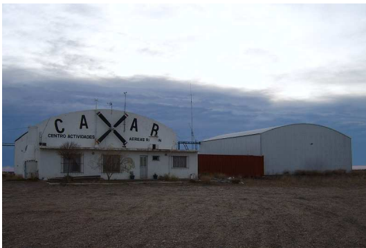
Hangares y oficinas
