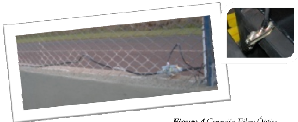
Figura 4. Conexión Fibra Óptica
