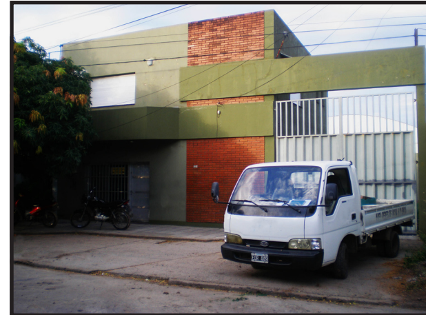
Fachada casa central
