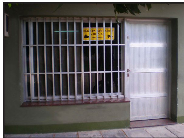
Puerta de ingreso
