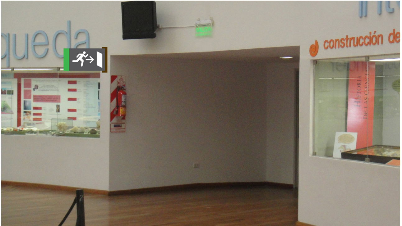
Señal Salida de Emergencia
